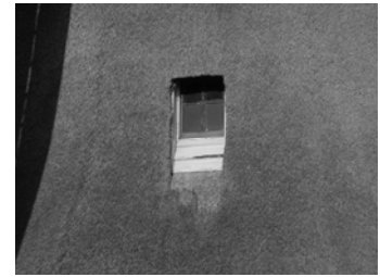
reparatie van het riet, net onder de ramen
