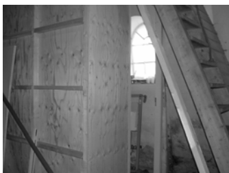
de verbouwing van de benedenverdieping in volle gang
