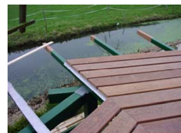
duurzame houtsoorten en loodslabben op de juiste plaats zorgen voor een stelling met een lange levensduur
