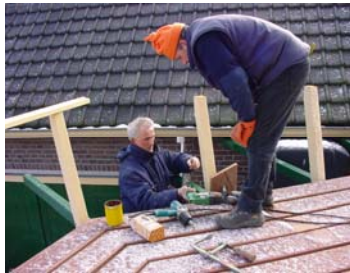
Aad van der Hulst en Mart Ruijgt bezig met het aanbrengen van het nieuwe hekwerk.
